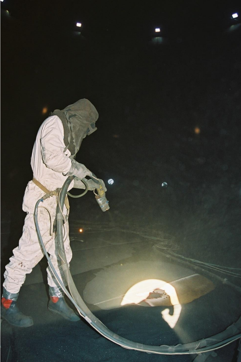
Kuva 1 Suihkupuhdistustyö käynnissä. (lähde Tikkurila Oyj:n kuva-arkisto)
