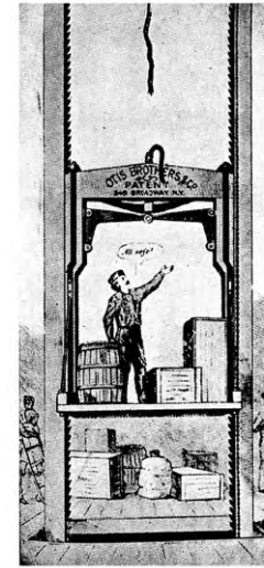
Hissin keksiminen oli korkeiden kerrostalojen edellytyksiä (Otis 1851). Aluksi hissit toimivat hydraulisesti höyryvoimalla.
