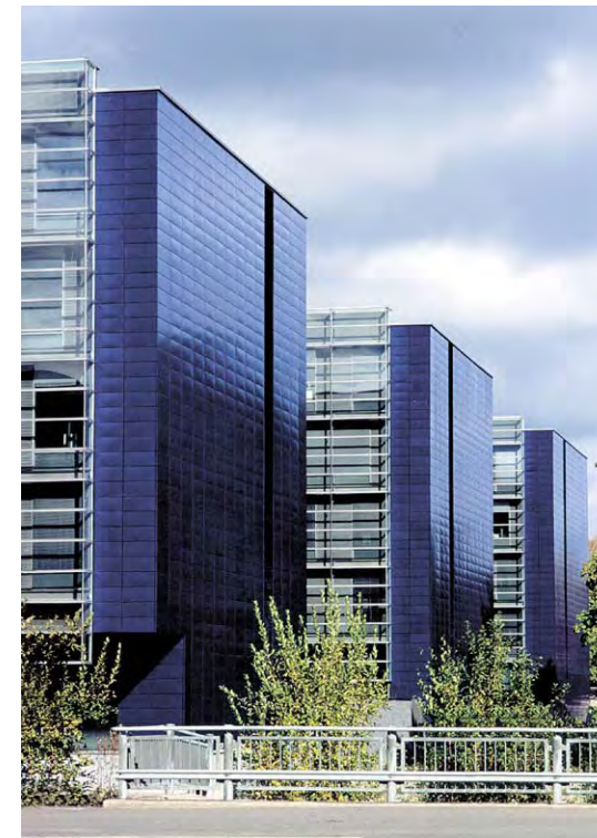
Koboltinsinisiksi emaloituja teräskasetteja. Kiinteistö Oy Helsingin Lepakko. Helin & Co arkkitehdit (2002)
