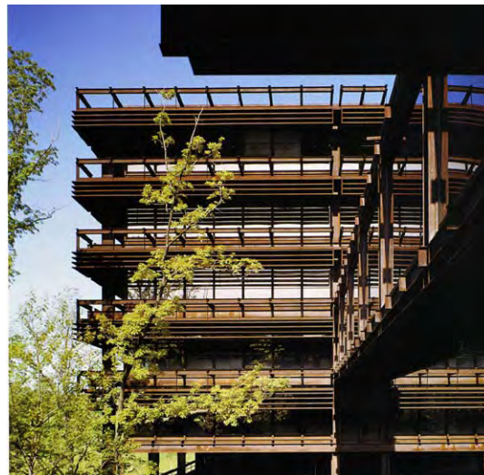
Eero Saarinen: Office block, Illinois (1963). Ensimmäisiä esimerkkejä COR-TEN –julkisivusta.
