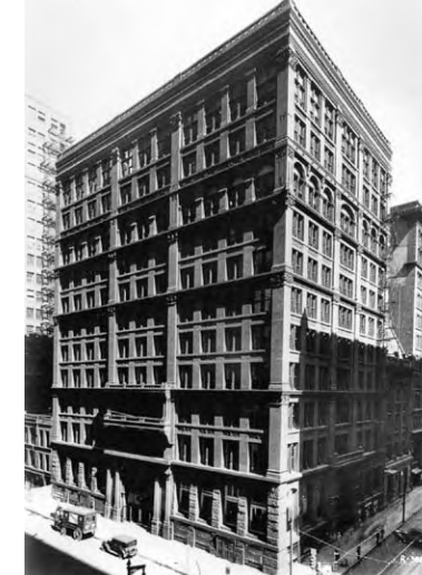
William le Baron Jenney: Home Insurance Building (1884, korotus 1890). Monikerrokset rautarungot tulivat mahdollisiksi, kun raudan laatu oli kehittynyt kyllin sitkeäksi kestäämään liitoksissa.
