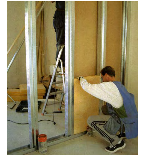
Termorangan reiät vaimentavat myös ääntä ja siksi ne soveltuvat huoneistojen välisiin levyseiniin.
