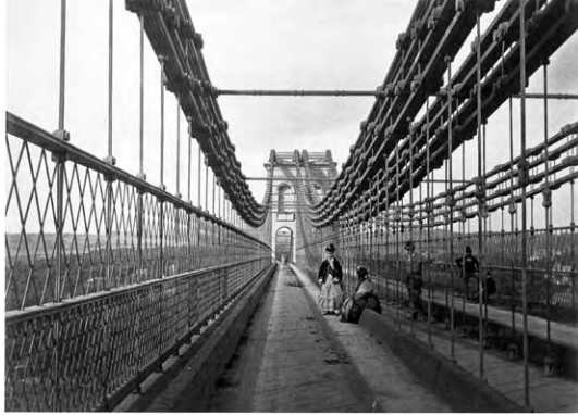
Thomas Telford: Menai Strait (1826). Sitkeämpi takorauta mahdollisti ketju- ja riippusillat. Jänne 174m.
