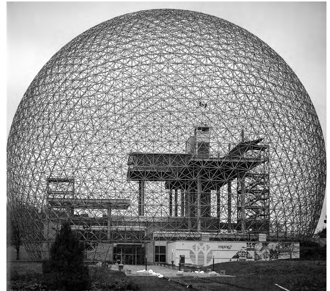
Buckminster Fuller: Montreal-paviljoni (1967). Terässauvat liitoskappaleineen muodostavat yhdessä suuren avaruusristikkokuplan.
