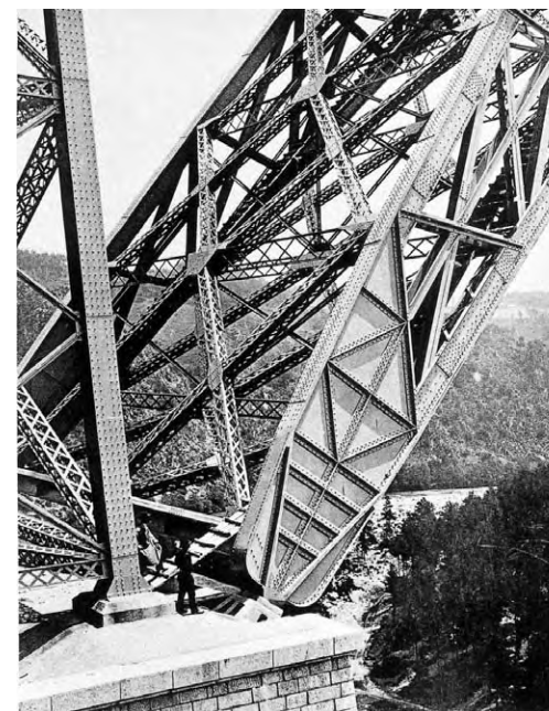
Vanha kuumaniitattu rakenne. Gustave Eiffel: Viaduc Garabit
