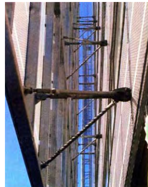
Kaksoisjulkisivun ripustuskiinnitys
