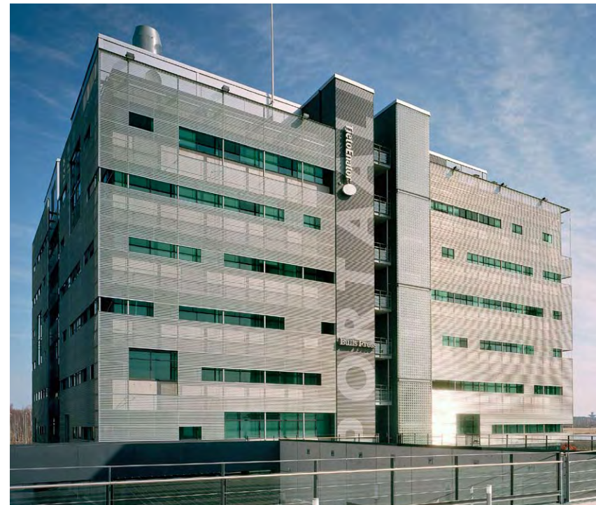
Levyverkko (expand-verkko) valmistetaan venyttämällä lävistettyä teräslevyä.
