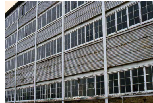
G.T. Greene: Boat Store, Sheerness (1869) on esimerkki teollisesta järjestelmärakentamisesta, jonka kaikki osat ovat esivalmistettuja. Käyttötarkoitus ei vaatinut koristeluja.
