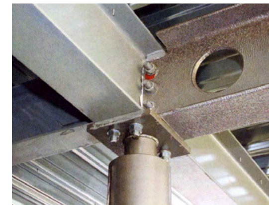
Palosuojamaalattujen rakennusosien pulttiliitos
