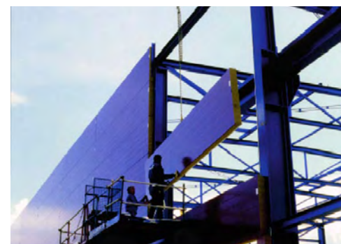
Kevytelementtejä asennetaan runkoon.
