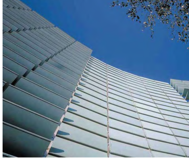
Säädettyjä auringonsuojia Pohjoismaiden suurlähetystö, Berliini. Arkkitehdit Berger & Parkkinen (1999)
