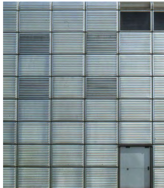
Alumiiniverhottu julkisivu. Norman Foster: Sainsbury Center (1974-78)
