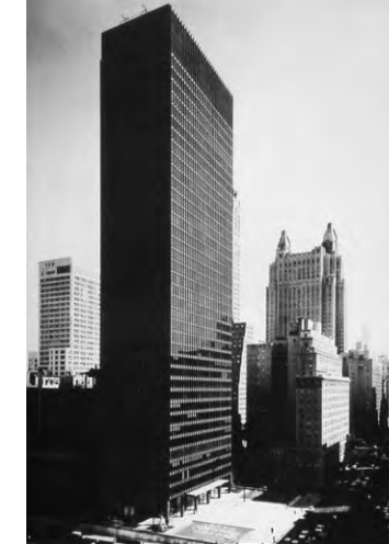
Mies van der Rohe: The Seagram Building, New York (1958). Julkisivusta on tullut verhomainen, ei-kantava rakenne (curtain wall). Kuuluista nurkkadetalji on seurausta teräs-laippapalkkirakenteesta.
