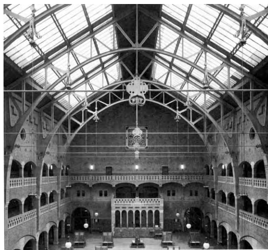
Henrik Petrus Berlage: Amsterdamin pörssi (1903). Niitit ja avoprofiilit antavat vielä oman ilmeensä arkkitehtuuriin.
