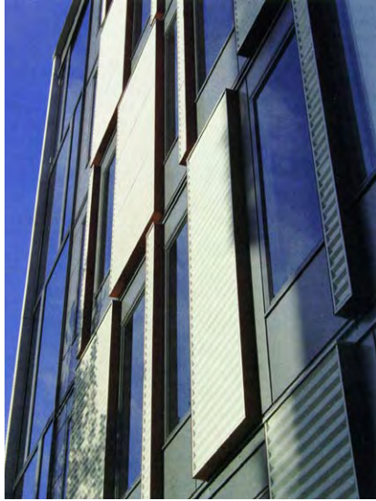
Termorankaelementtejä julkisivussa. Kilon terveysasema. Arkkitehtitoimisto Brunow & Maunula (2004)
