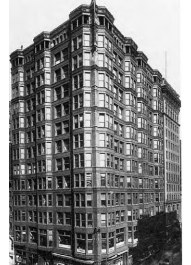
Holabird & Roche: The Tacoma Building, Chicago (1887). Rautarunko koottiin niittaamalla ja ilman telineitä ahtaassa kaupunkitilassa.
