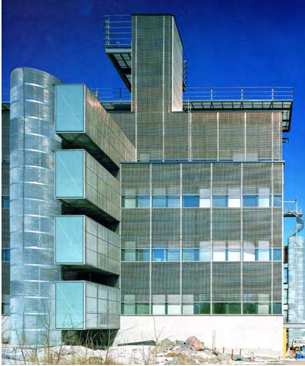
Kantavan julkisivun edessä on alumiiniritilöitä lasikaistoinen. Helsingin Yliopisto Physicum. Arkkitehtitoimisto Lahdelma & Mahlamäki Oy (2001)
