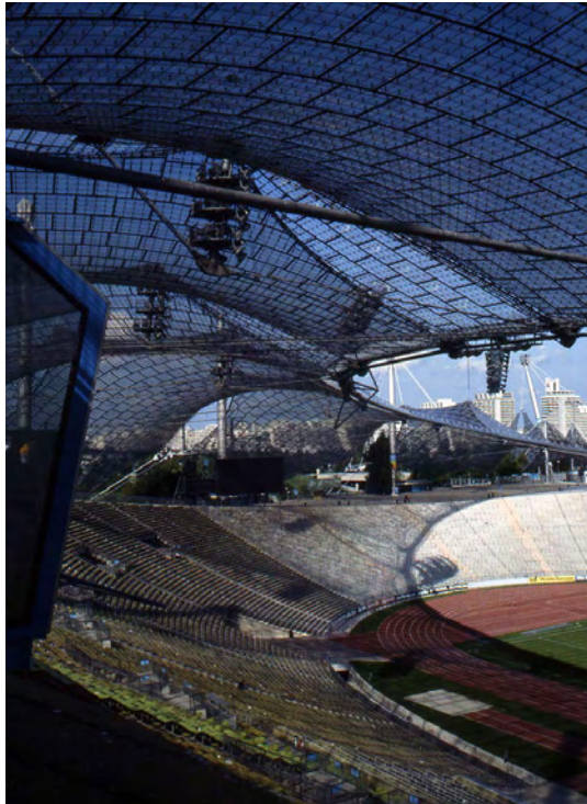
Behnisch & Partner: Münchenin olympiastadion (1972). Riippusillat ovat jo vuosikymmeniä innoittaneet muitakin rakentamista.
