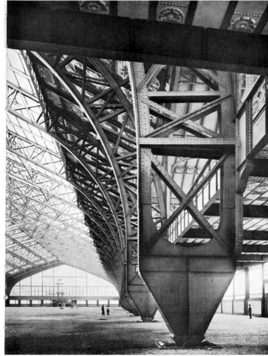
Dutert & Contamin: Galerie des Machines, Pariisi (1889). Tämän valtavan teräshallin suurin jänneväli oli 115 m.
