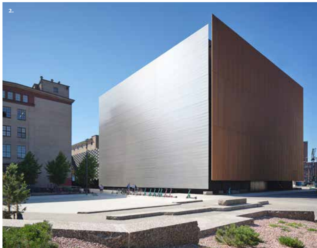
Kuvat 1–2: Ruoholahdessa sijaitseva Tanssin talo on Suomen ensimmäinen tanssin ehdoilla suunniteltu kiinteistö. Samalla se toimii maamerkinä Ruoholahdessa ja Helsingissä laajemminkin. Julkisivun leijuva efekti on luotu teräsrakenteisiin tukeutuen.
