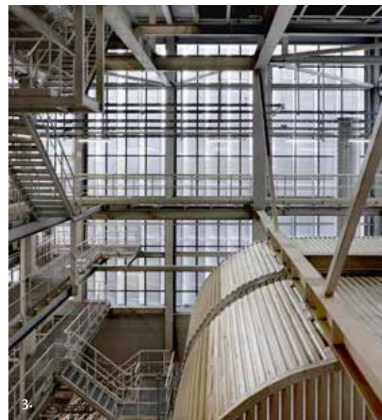
Kuva 3: Vuosaaren uuden biolämpölaitoksen teräsrakenteita.
