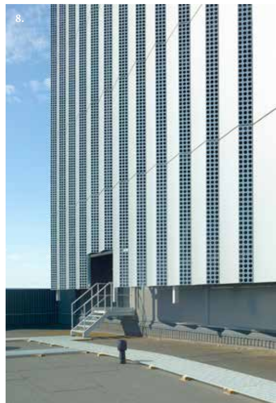
Kuva 8: Mittatilaustyönä suunnitellut kolmiulotteiset kasetit profiloivat julkisivua upeasti.
