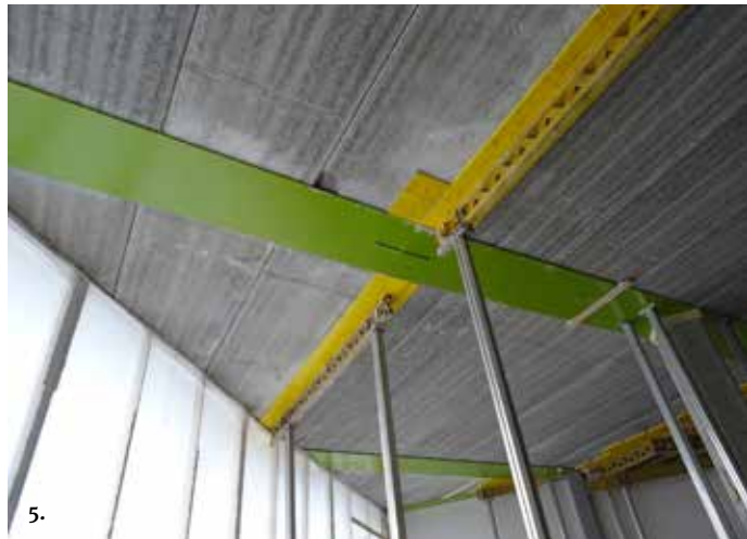
Kuva 5: Tarvittaessa Deltapalkki joustaa uusiin ratkaisuihin. IV-konehuoneen katossa sitä taivuttamalla päästiin eroon tilaa vievästi pilarista.
