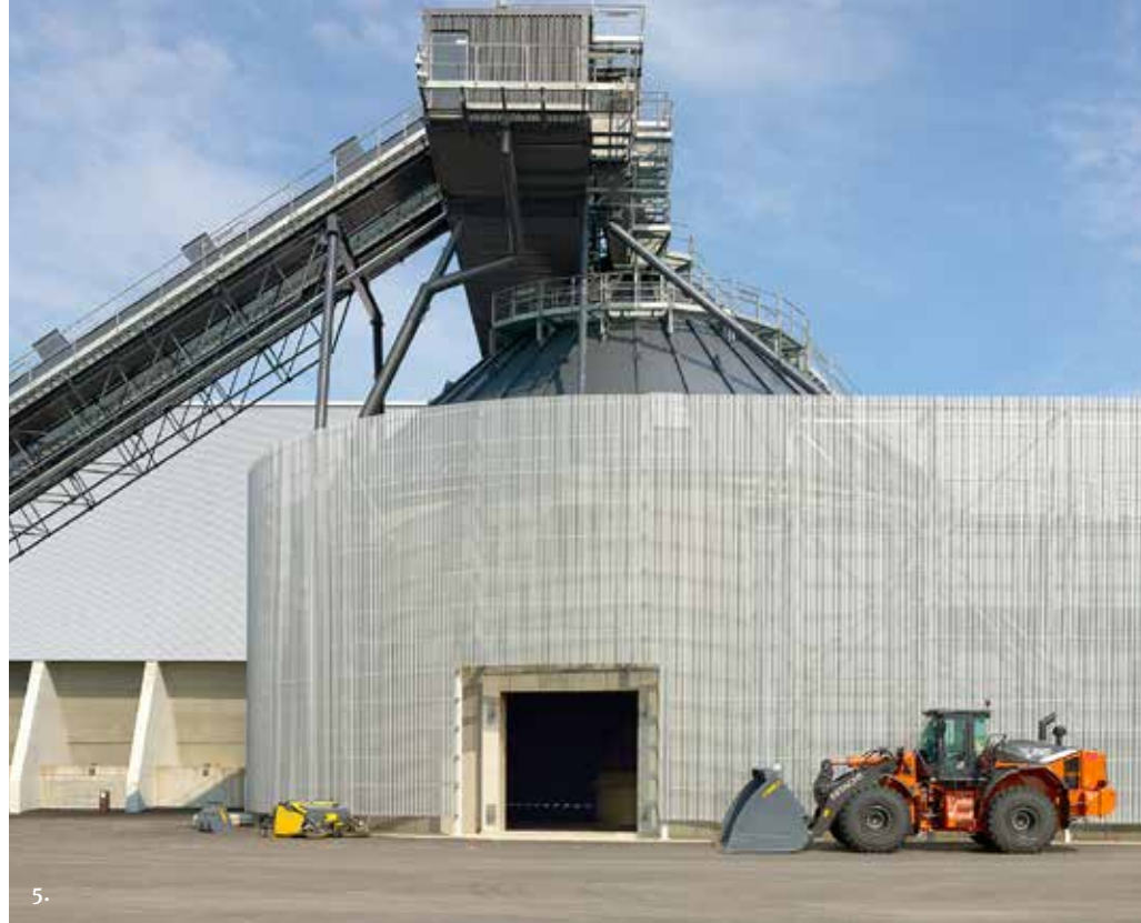
Kuva 5: Teräs ja alumiini luovat ilmettä Vuosaaren uudelle biolämpölaitokselle.
