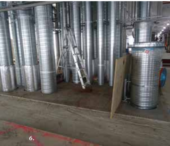
Kuva 6: Tekniikkakuiluun tuli Pektralta yhtenäinen teräslaatta, johon tehtiin työmaalla sopivat aukot putkille.
