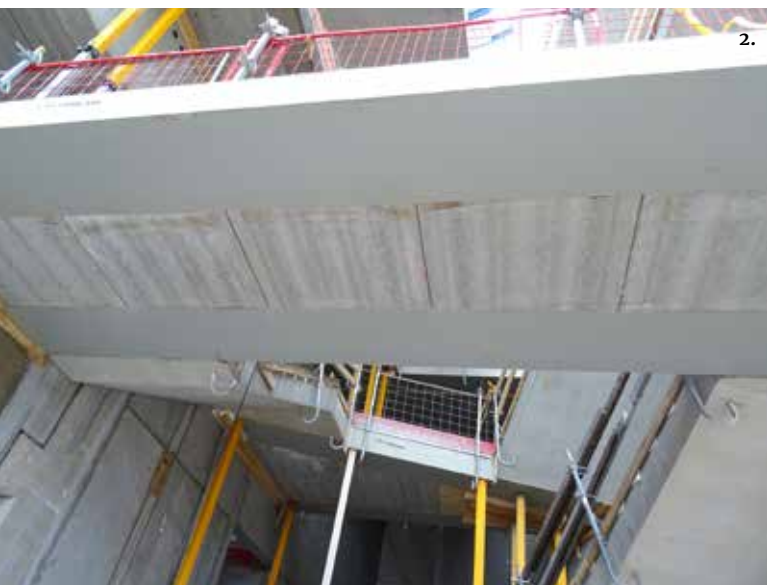
Kuva 2: Peikon Deltabeam-liittopalkit toimivat yhdessä monimuokkaistenkin rakenteiden kanssa.
