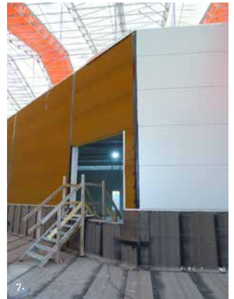
Kuva 7: Roihupellon kampuksessa on pelti-villa-pelti-elementtejä sekä corten-pintaisena että kiiltävänä. Ruukki on toimittanut kohteeseen pelti-villa-pelti-elementtejä.
