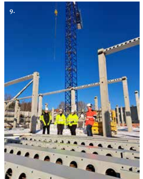
Kuva 9: Deltabeam-palkkien asennusta ovat seuraamassa (vasemmalta oikealle) Peikon myyntipäällikkö Esa Hynninen, palkkitoimituksesta vastannut Sari Lindgren ja kohteen projektipäällikkö Elina Hietanen sekä Lujatalon vastaava työnjohtaja Jari Laulajainen.
