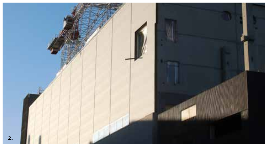
Kuva 2: Okmeticin laajennusosan Köyhämäentien suuntaisen julkisivun Paroc-elementtejä marraskuussa auringonpaisteissa.
