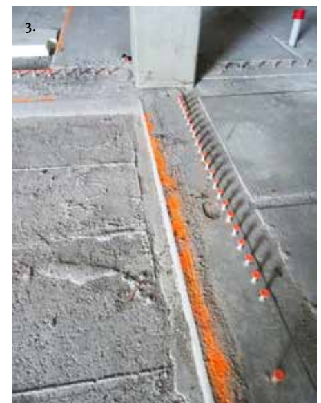
Kuva 3: Deltabeam-palkkeihin kiinnitetyt vaarnat on maalattu helposti huomattaviksi.
