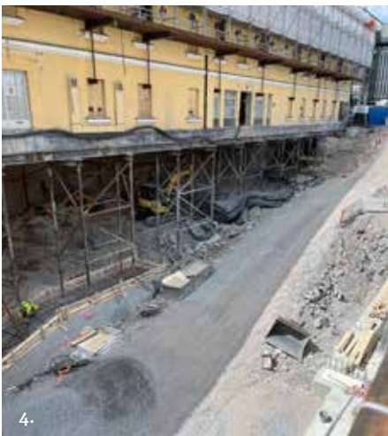
Kuvat 1–6: Kulttuurikasarmin työmaalla hyödynnettiin terästä monella tapaa myös työnaikaisissa rakenteissa.
