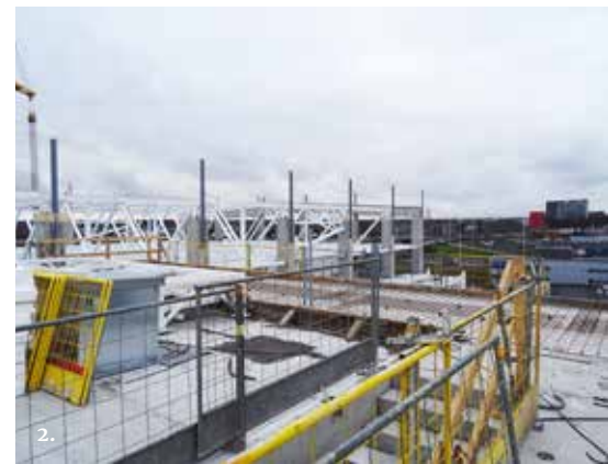
Kuva 1: Ristikot ja teräsrakenteet ovat massiivisia ja terästä on kohteessa kaikkiaan 1800 tonnia.
