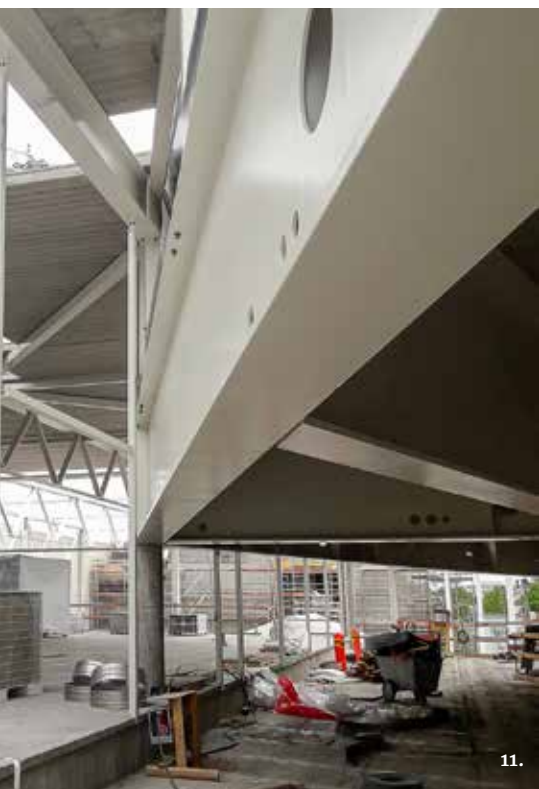
Kuvat 11: Kampuksen teräsrakenteita kuvattuna rakennustöiden aikana.
