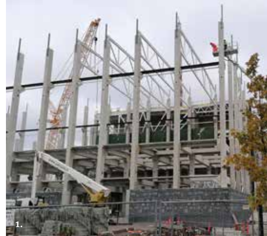
Kuvat 1 ja 2: Kavametin Okmetecin tehdastyömaalle toimittamia teräsrakenteita.
