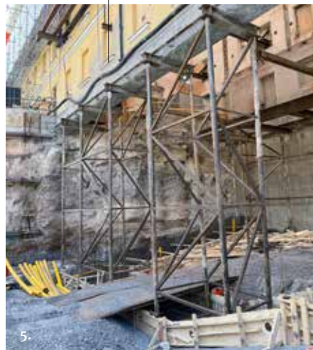
Kuvat 1–6: Kulttuurikasarmin työmaalla hyödynnettiin terästä monella tapaa myös työnaikaisissa rakenteissa.
