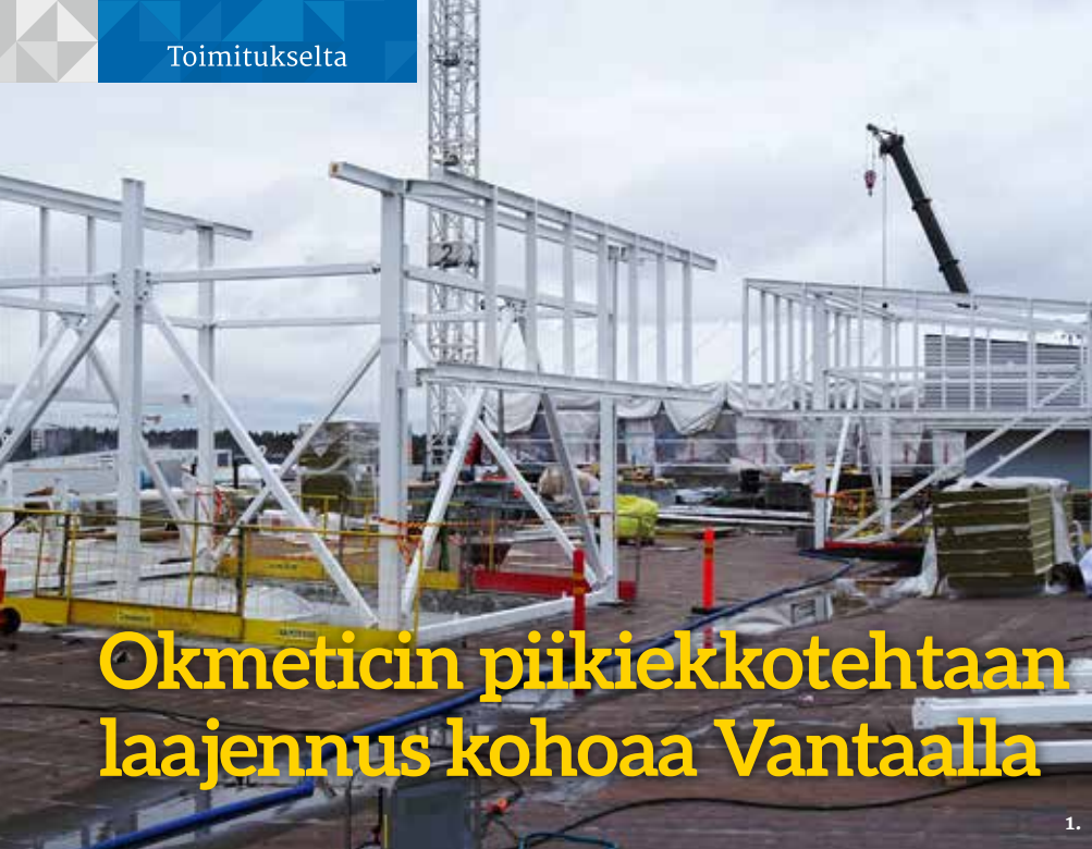
Kuva 1: Ristikot ja teräsrakenteet ovat massiivisia ja terästä on kohteessa kaikkiaan 1800 tonnia.
