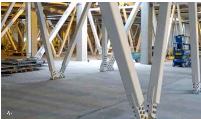
Kuva 4: Jokaiseen isoon ristikkoon meni 250 HV 10.9:n pulttia. Nämä järeät pultit painavat yli kilon kappaleelta ja niitä käytetään vain erityisemmissä paikoissa.
