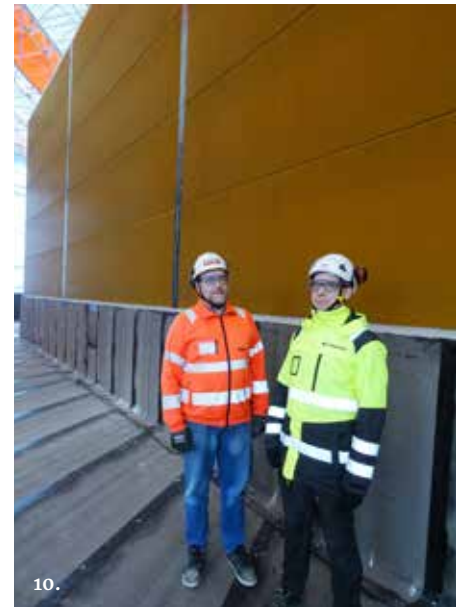
Kuva 10: Tomi Varonen ja Teemu Ahonen ovat tyytyväisiä siihen, että corten-pinta alkoi ruostua tasaisesti heti asennuksen jälkeen.
