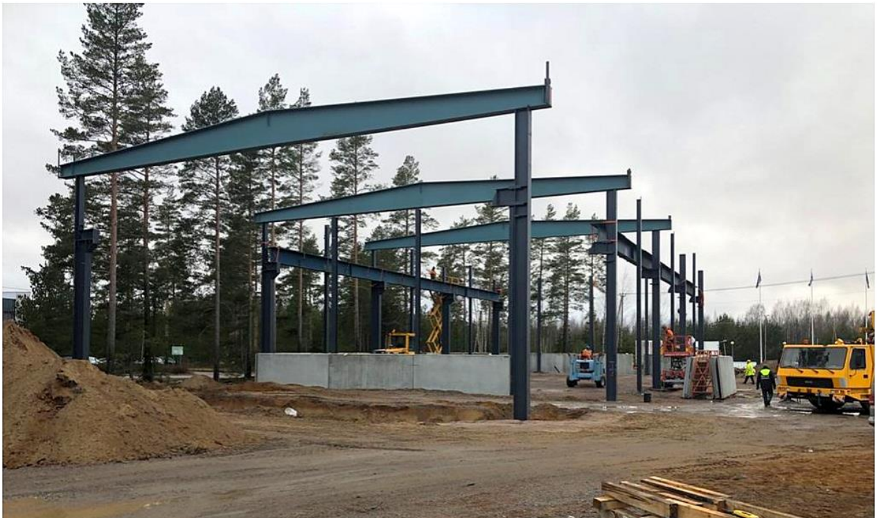
Kuva 4. Runkorakenteiden asennusta uuteen käyttökohteeseen [34].
