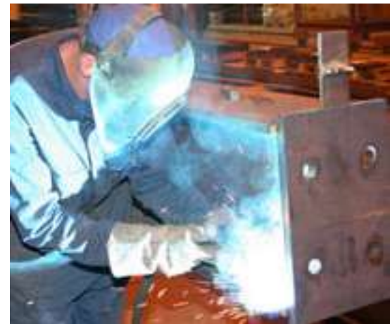
”Tästä uhkaa tulla ihan katastrofi”, arvioitiin Teräsrakenne-lehden artikkelissa vuoden 2014 heinäkuun alussa pakolliseksi tulossa olleeseen CE-merkintään valmistautumista.
