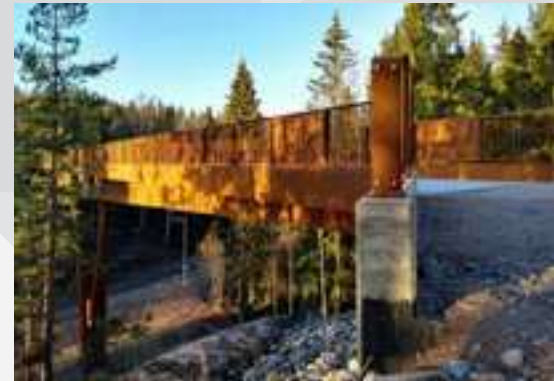
Sipoonkorven kevyen liikenteen silta, kunniamaininta Vuoden Teräsrakenne-kilpailussa 2020.
