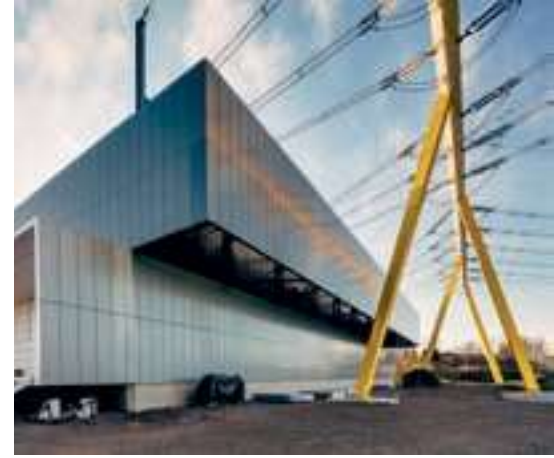
Vuoden 2014 Teräsrakenne Viikinmäen voimajohdtopylväs.
