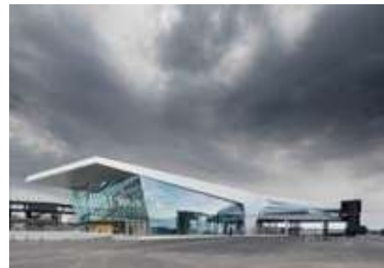
Länsiterminali 2 Vuoden Teräsrakenne 2017.
