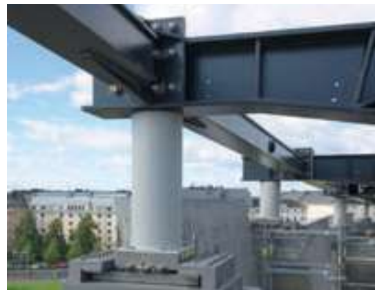
Vuoden Teräsrakenne 2019 olivat Olympiastadionin uudet katokset, joissa on järeät ja vaativat teräsrä- kenteet.
