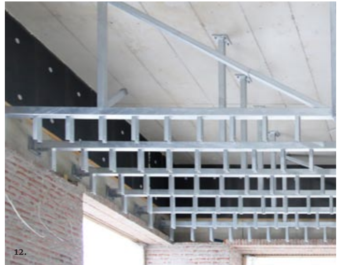
Kuva 11: Teräsnyrkki Steelin toimitusjohtaja Ville Punnonen tutkaillee yhtiön valmistamia Kaikukatu 5:n lasikaton teräsrakenteita. Lasien asennus teräsrungon päälle kuuluu myös Teräsnyrkin urakkaan. Varsinaisen tukirakenteen päälle on kiinnitetty ruuveilla säädettävät listat, joiden päälle lasit sitten asennetaan niiden vaatimaan toleranssimaailmaan.
