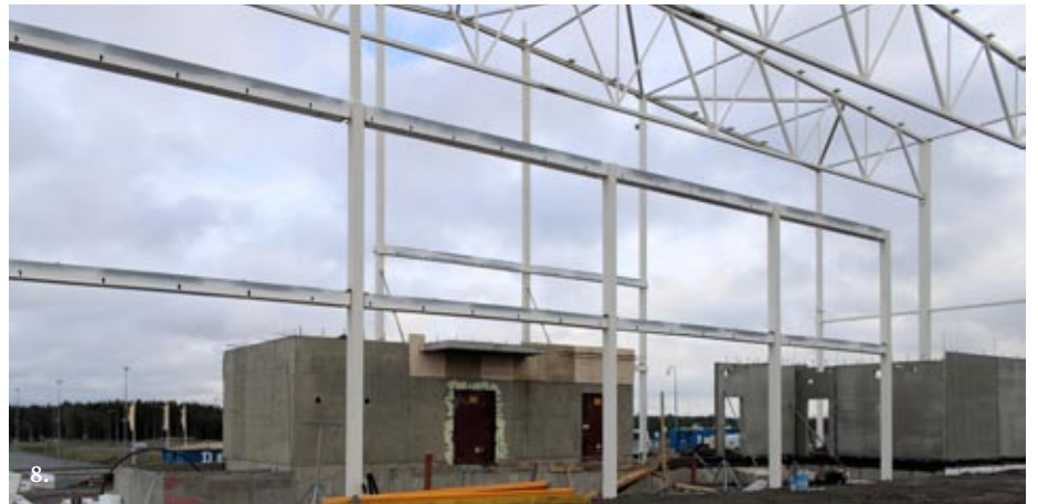
Kuvat 5-8: PostNordin toiminta tapahtuu Tampereen seudulla vuodesta 2021 lähtien terminaalissa, jossa on Beam-Net Oy:n toimittama teräsrunko, jonka tuoteosakaupan suunnittelijana on toiminut SS-Teracon Oy, ja ulkoseininä Inveco Oy:n toimittamat IzoWall-uretaanisandwichelementit.
